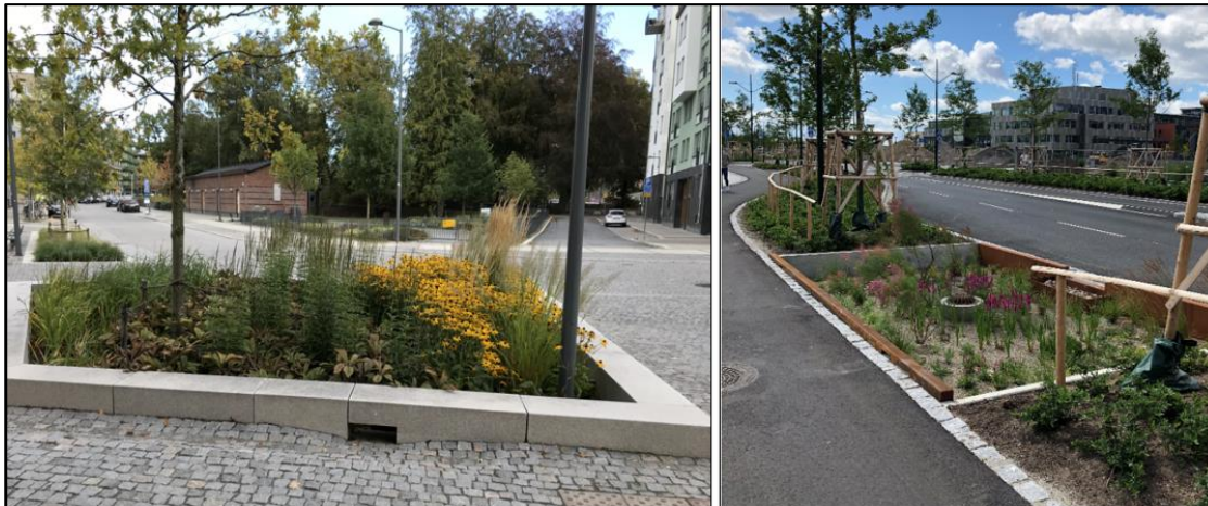
Figur 16. Exempel på nedsänkta regnbäddar (Foton: Norconsult)
