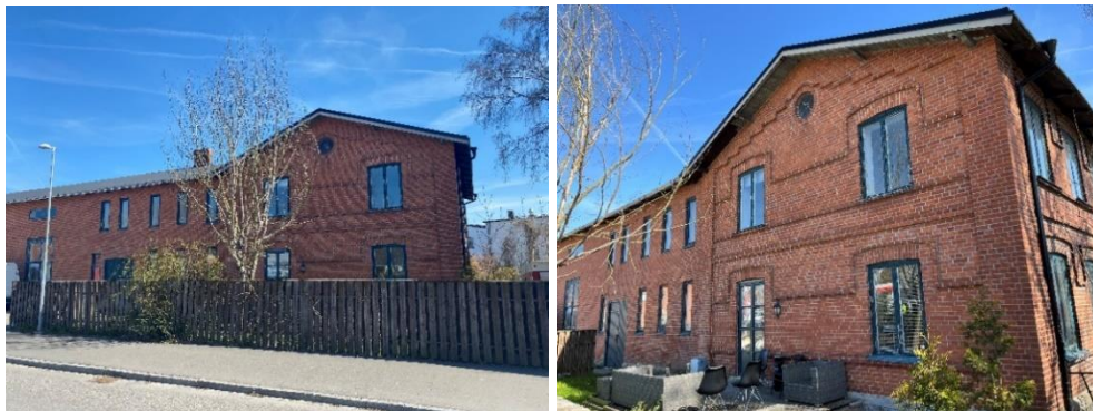
Den kulturhistoriskt värdefulla byggnaden inom fastigheten Kajan 10. Byggnaden visar på den tidstypiska tegelarkitekturen, som bedöms vara särskilt värdefull för Vellinge.
