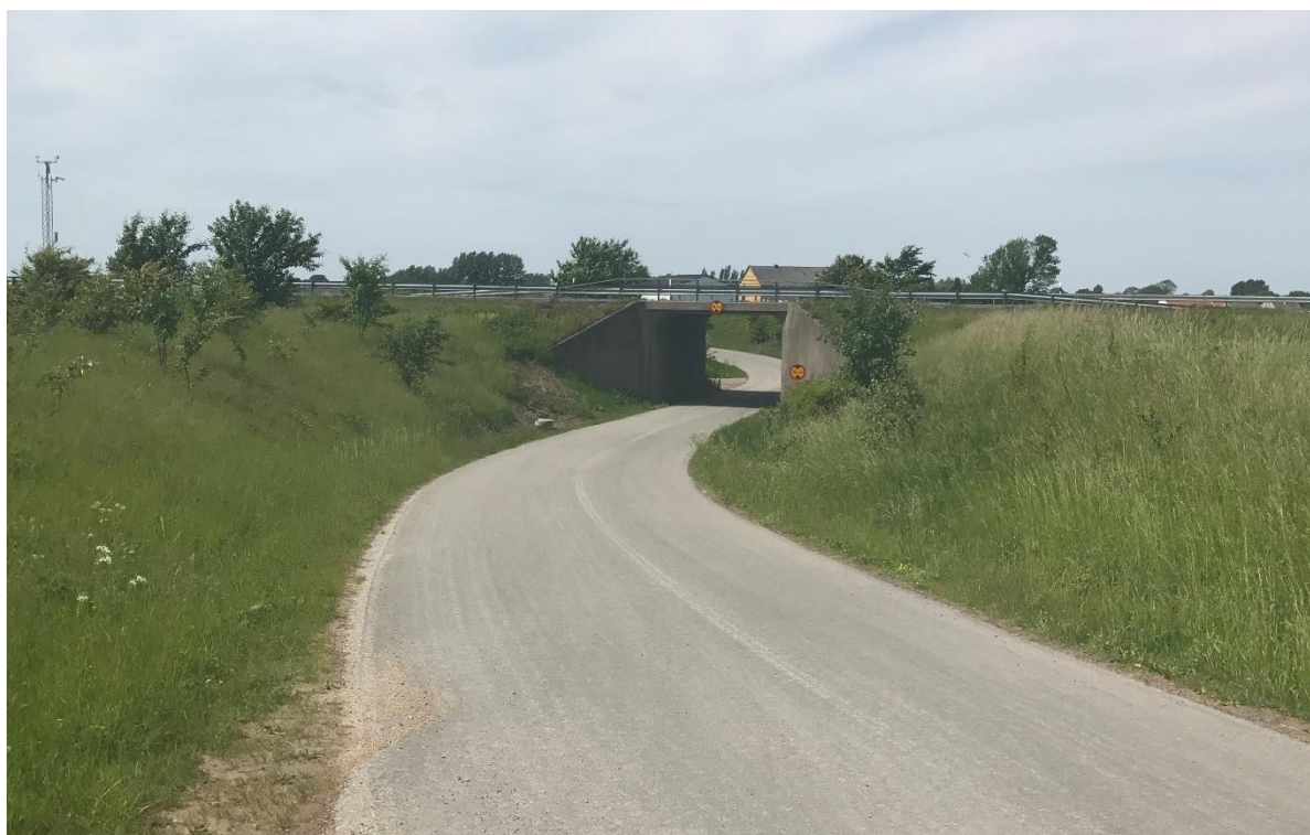
Åkeshögsvägen, tunneln under väg 100.
