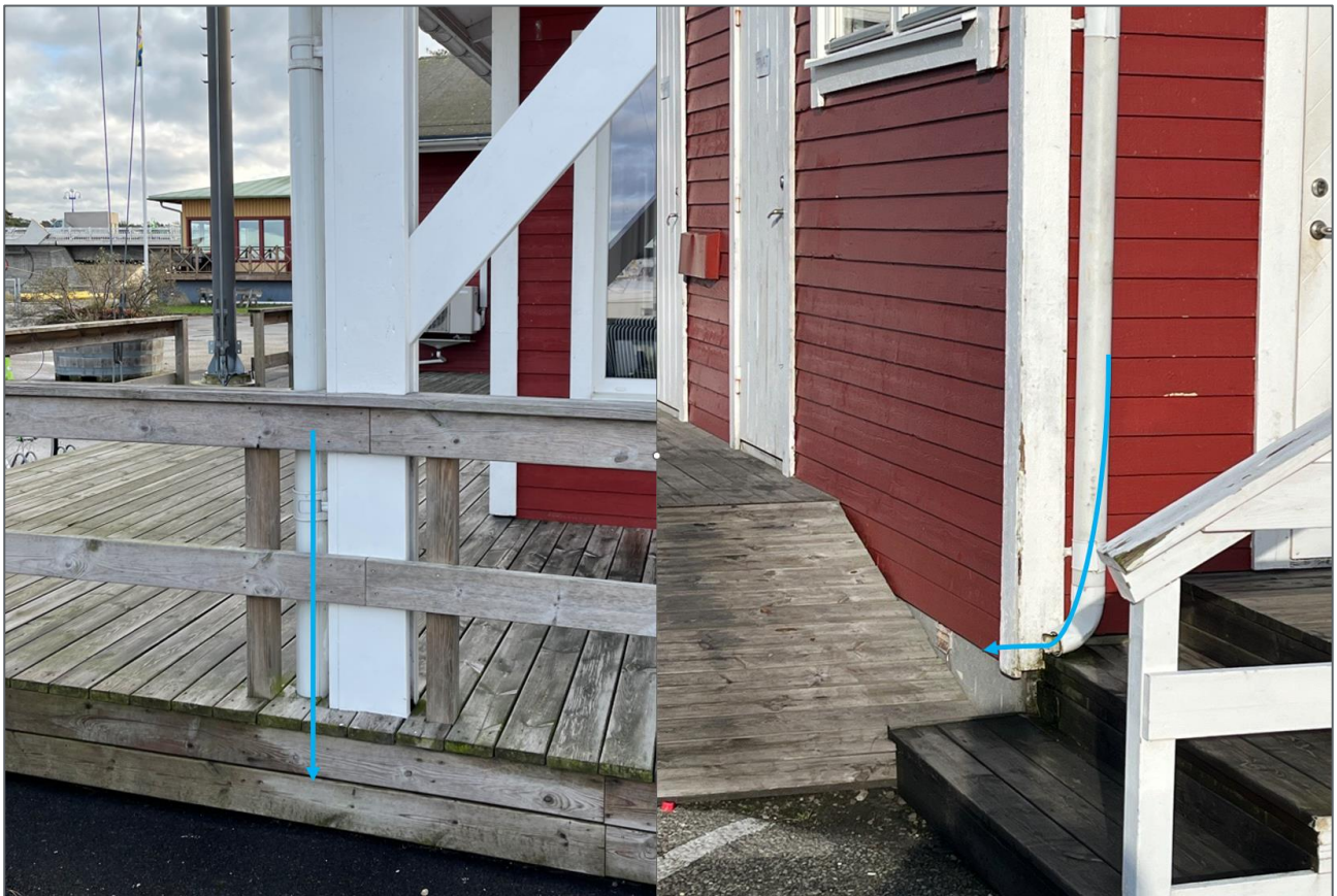
Figur 12. Stuprör som leds ner i marken till vänster och utkastare till höger.
