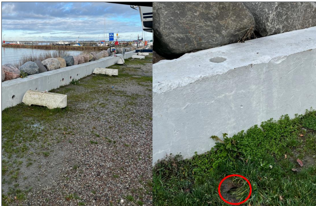
Figur 13. Mur längsmed grusparkeringen samt ett utlopp för yttlig avrinning till höger.
