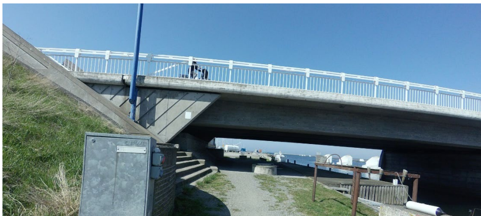
Grusväg under bron, vy från söder mot Västra hamnplan. Källa: Mapillary 2018.
