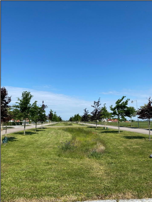
Figur 7. Bilden till vänster visar diket i esplanaden intill skolan. Den högra bilden visar dammen där dagvatten från området tas omhand.
