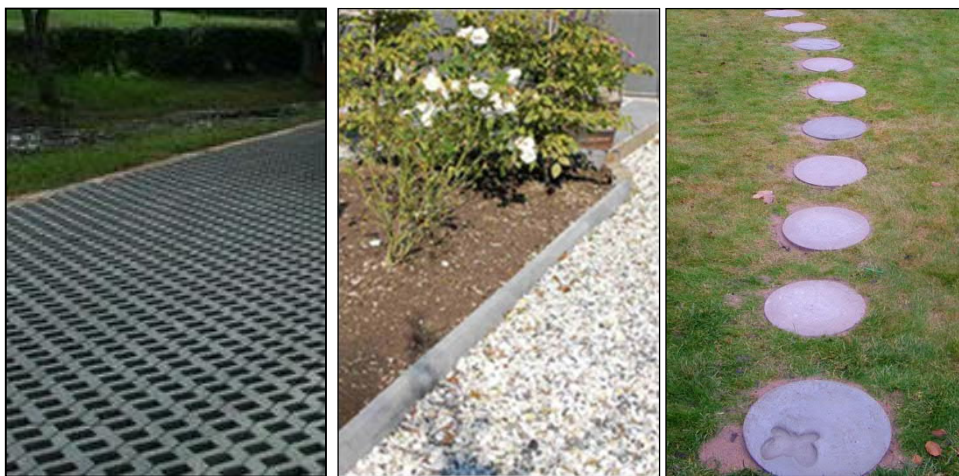
Figur 15. Yta med hålsten av betong, makadambelagd gång, samt gångstig med gräs och några gångplattor i betong (Foto: Norconsult)
