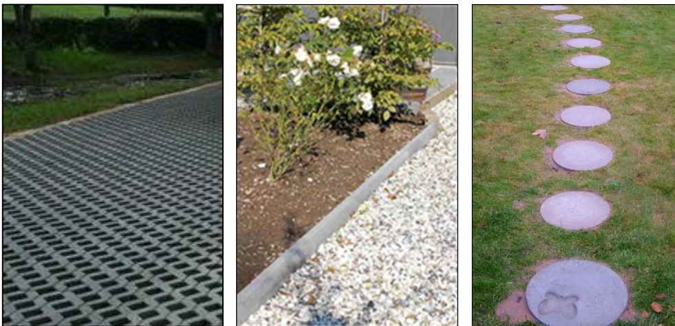
Figur 15. Yta med hålsten av betong, makadambelagd gång, samt gångstig med gräs och några gångplattor i betong (Foto: Norconsult)
