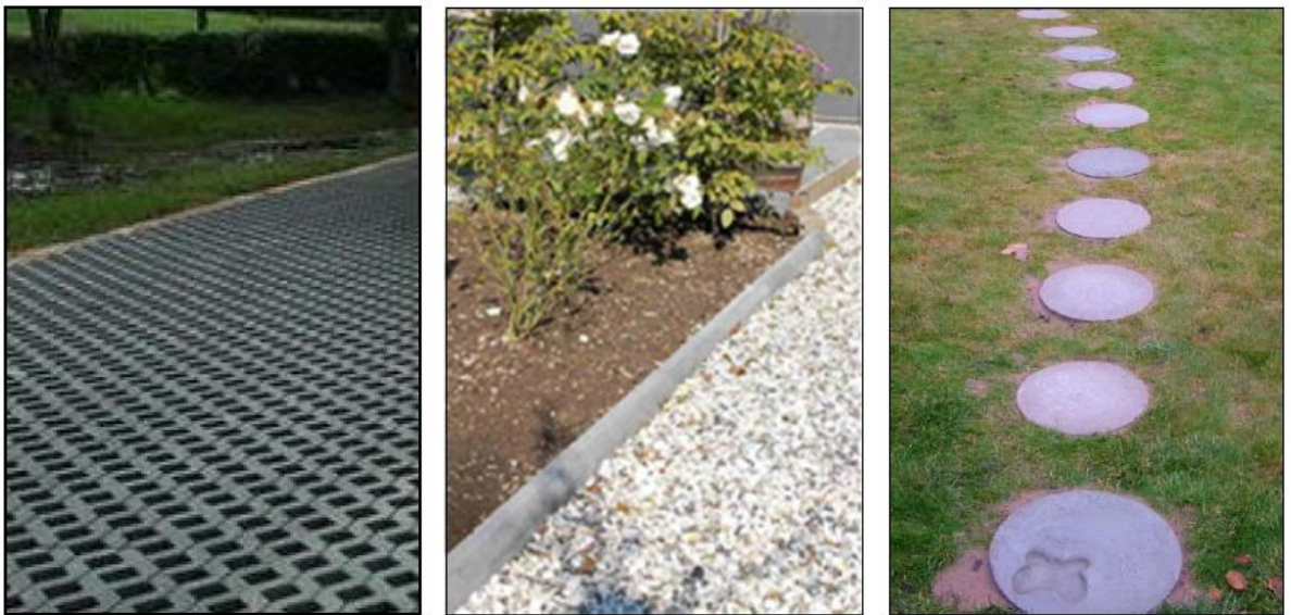
Yta med hålstén av betong, makadambelagd gång, samt gångstig med gräs och några gångplattor i betong (Foto: Norconsult).
