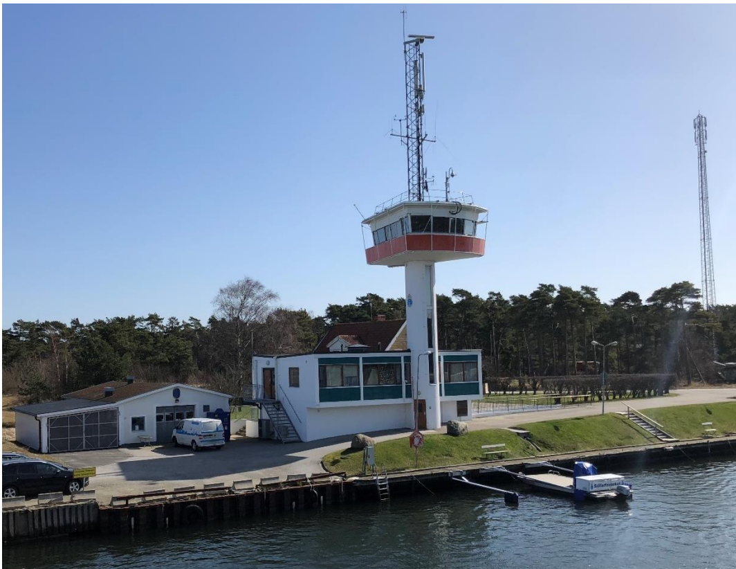
Kanalvaktartornet med verkstadsbyggnad
