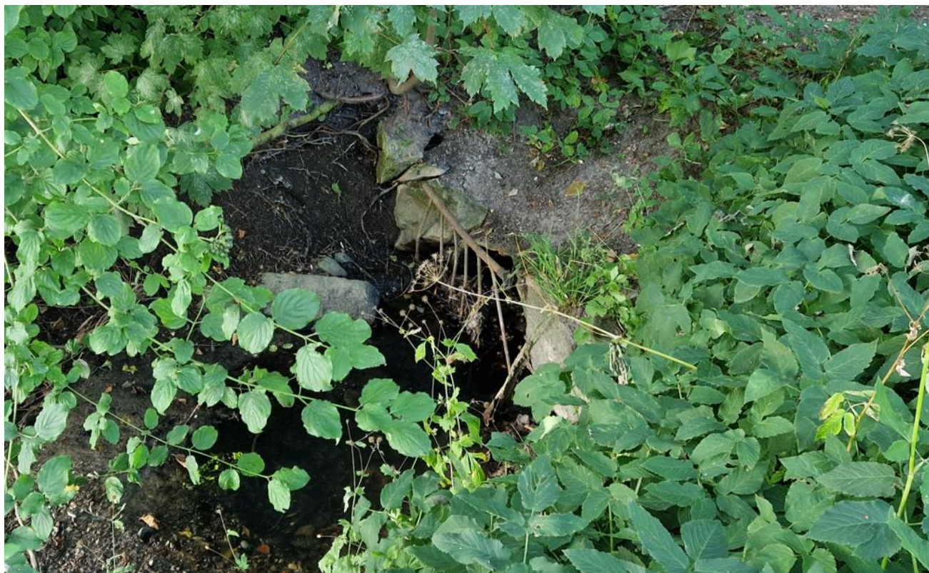
Figur 9. Utlopp till kulverterad del av dikningsföretaget, tillika del av kommunala ledningsnätet.
