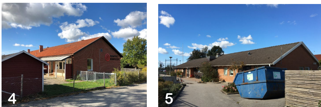
Bilden visar de två förskolebyggnaderna som låg i norra delen av planområdet före rivning.
