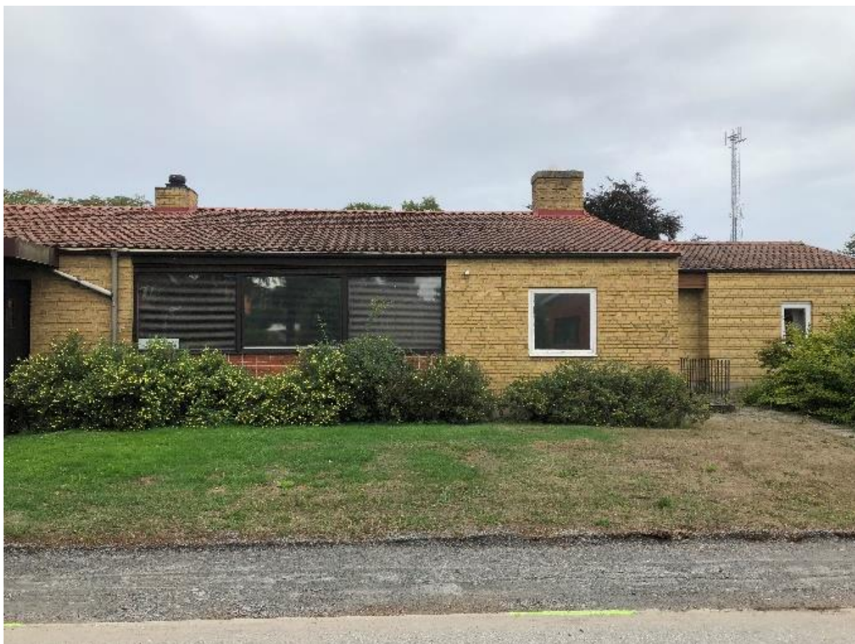
Norra delen av den östra fasaden. Här syns också tillbyggnaden i norr.
