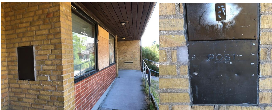
Den tidigare kontorsdelen är idag pizzeria. En postlåda i väggen visar byggnadens användning som postkontor.
