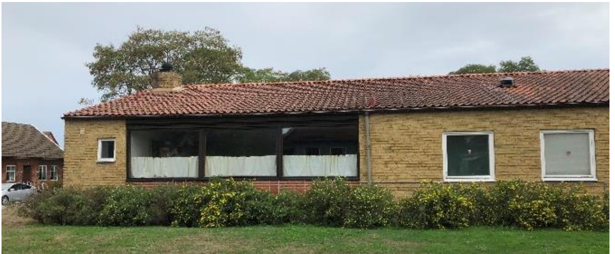
Södra delen av den östra fasaden.
