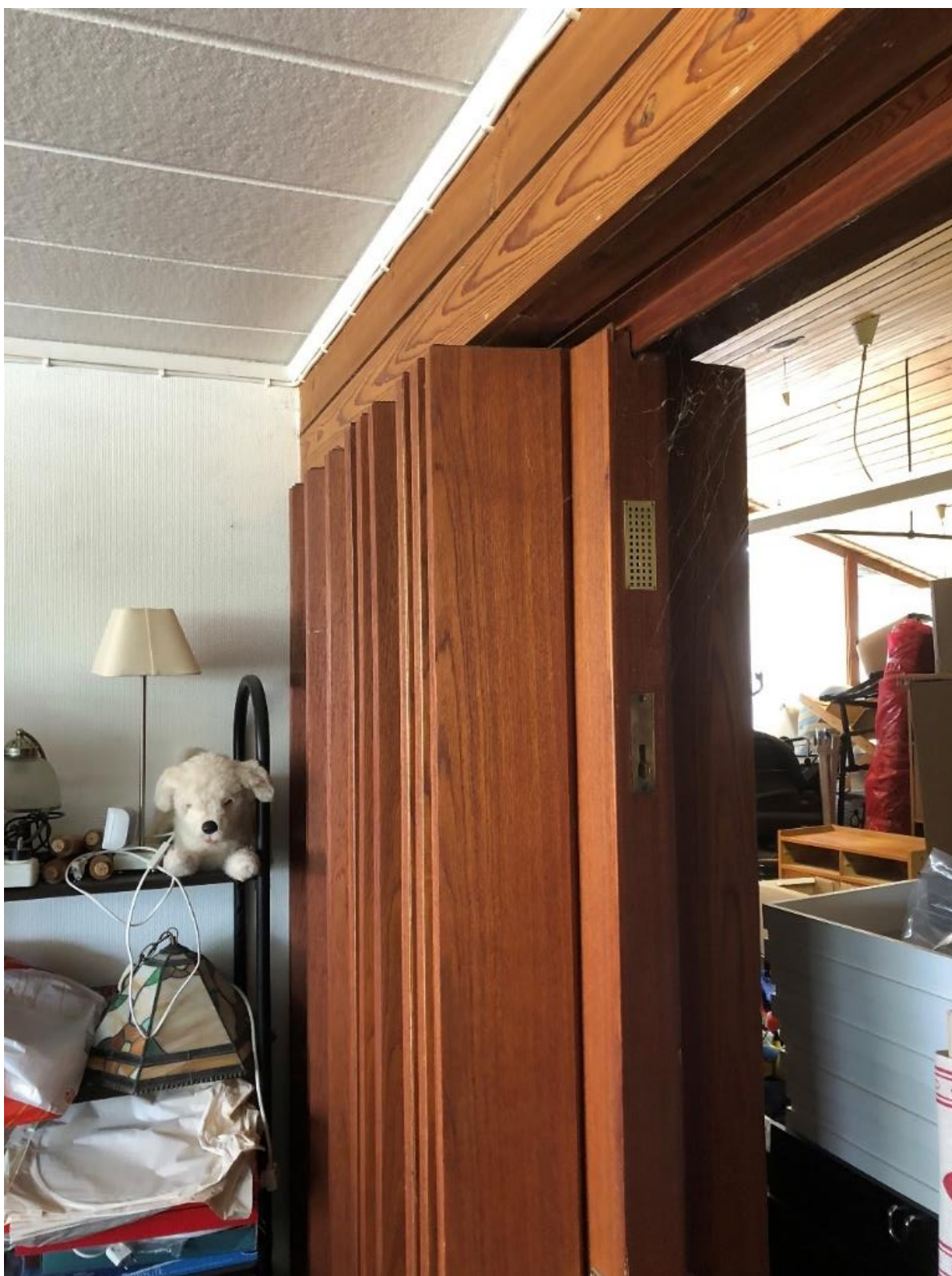
Vikdörren mellan det ursprungliga fullmäktigerummet och nämndsrummet är bevarad.
