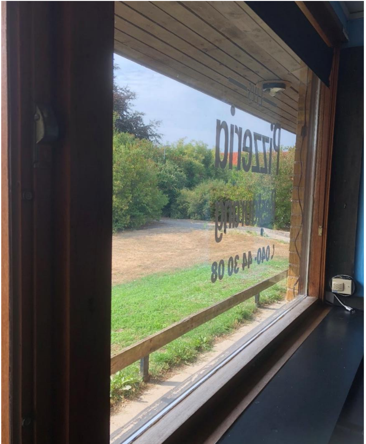
Fönsterparti i den mellersta delen, nu pizzeria. Av de tre fönstren är de yttersta i karm och mittfönstret pivåhängt.
