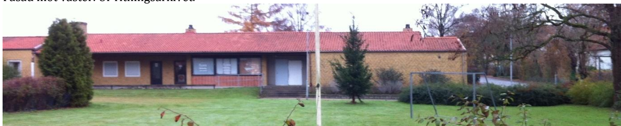
Byggnaden mot väster idag.
