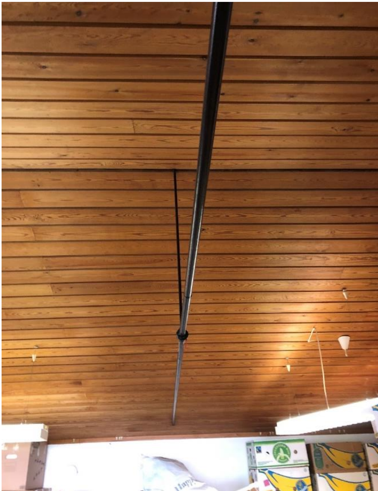
De karakteristiska dragstängerna i taket tydliggör spännvidden i det rymliga fullmäktigerummet.
