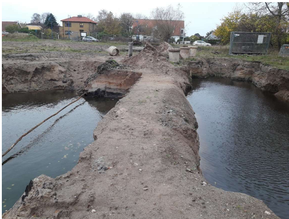
Figur 6. Vatten från schaktgroparna provtogs innan det pumpades bort. Det konstaterades att vattnet kunde släppas på dagvattennätet.
