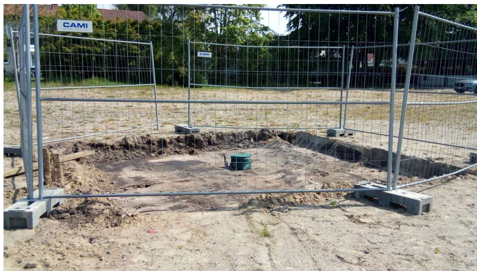
Figur 1. Saneringen inleddes med urschaktning runt konstaterade föroreningar. Provtogs i schaktväggar och schaktbotten
