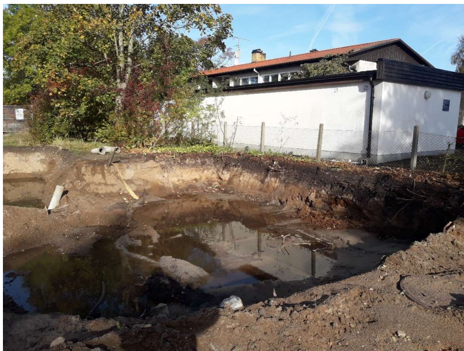
Figur 5. Schaktningen fortsatte ut till fastighetsgräns. Schaktväggen konstaterades ren och inga föroreningar har lämnats i fastighetsgräns.
