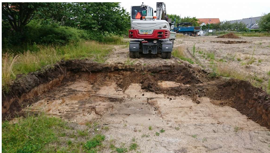
Figur 3. Påträffade föroreningar schaktades ur och jorden lades direkt på lastbil.
