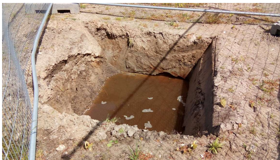
Figur 2. Provgropar utfördes för att avgränsa påträffade föroreningar
