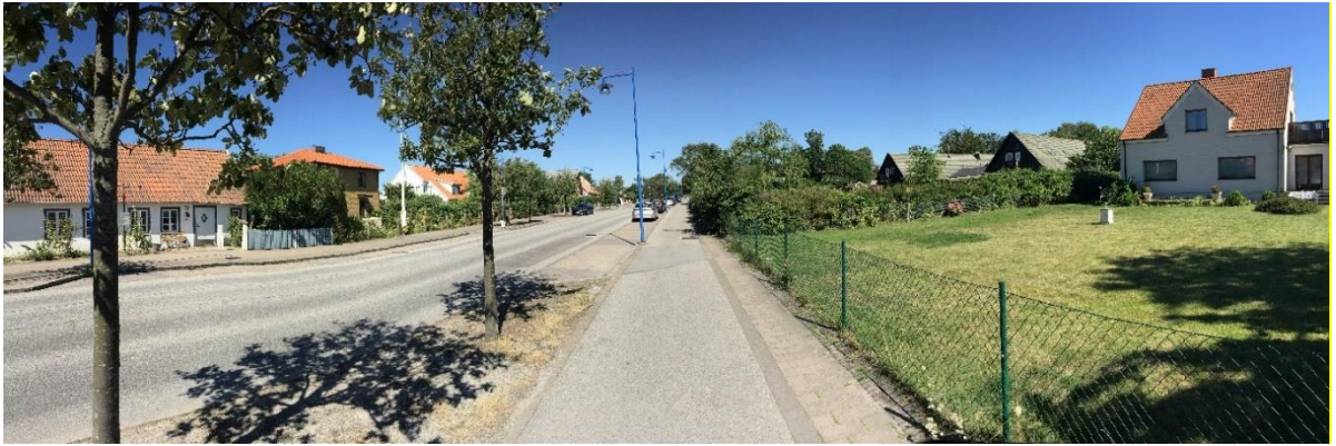
Bild tagen från Falsterbovägen före rivning av Mariastugan som ligger bortåt i bilden på höger sida.
