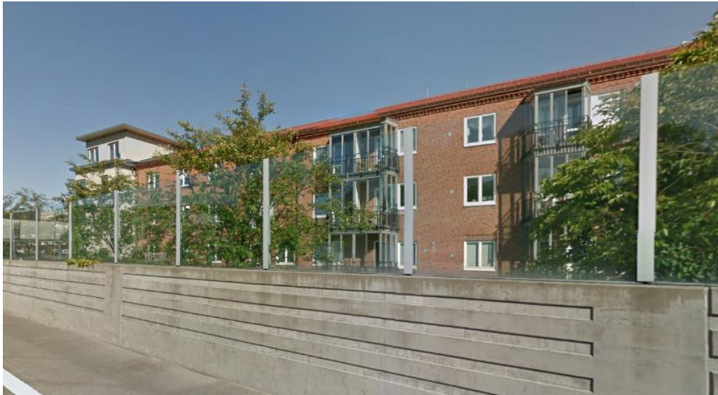
Figur 3-2 Längs E20 i Partille bullerskyddas flerbostäderna bland annat med hjälp av inglasade balkonger. (Bildkälla: Google)
