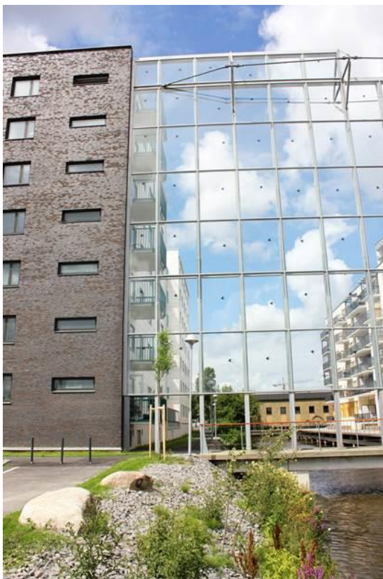
Figur 3-3 Exempel på hur en transparent skärm kan sättas upp mellan två huskroppar för att åstadkomma tyst sida. Detta exempel är taget från Porslinsfabriken i Göteborg. (Källa: www.cembrit.se )
