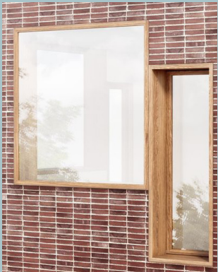
Träkarmar mot tegel i olika form och tjocklek
