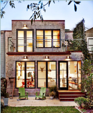
Terrass som integrerats väl i fasaduttrycket
