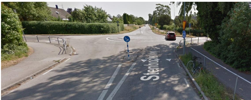
Figur 20. Befintlig gångpassage över Stenbocks väg vid Henriksdalsvägen, sett från norr (Källa karta: Google maps).
