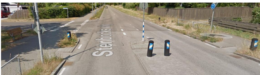
Figur 22. Befintlig passage med reflexpollare längs Stenbocks väg vid Ljungdalavägen (Källa karta: Google maps).
