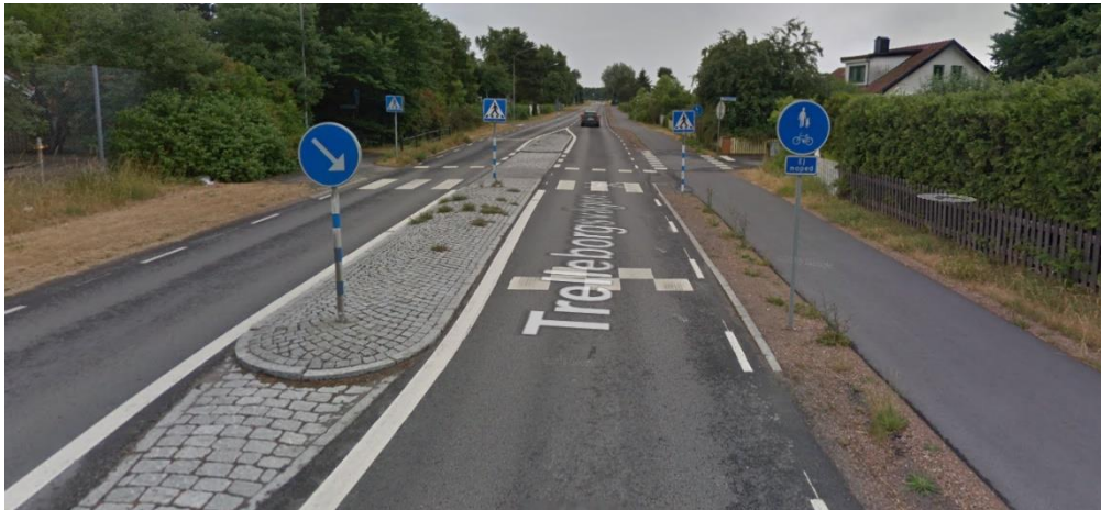
Figur 23. Befintlig hastighetssäkrad gång- och cykelpassage längs Trelleborgsgatan vid Penségatan (Källa karta: Google maps).
