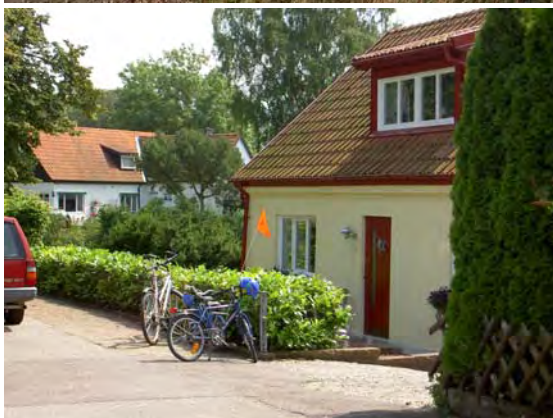
Gatehus vid Bäckavägen
