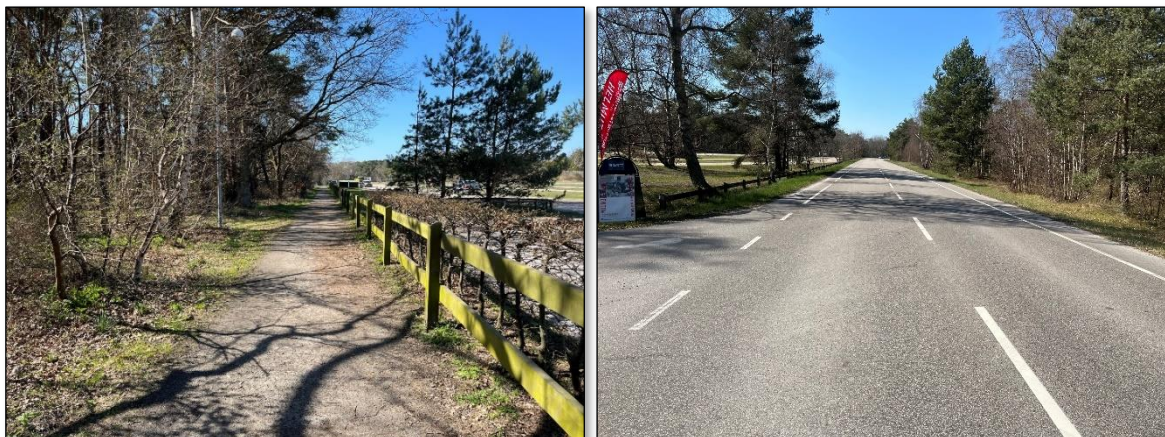
Figur 4. Utformning av gång- och cykelvägar i området. Karta till vänster visar gång- och cykelstråket söder om parkeringen. Kartan till höger visar utformningen av Strandbadsvägen där gång- och cykling sker i blandtrafik. Bildkälla: WSP.
