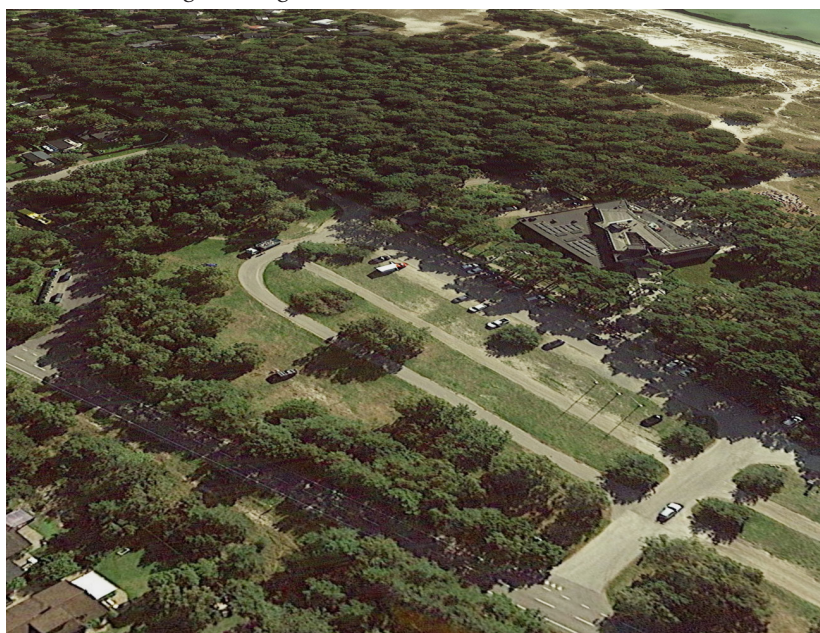
Befintlig byggnad och delar av parkeringsytan sett från nordväst.
