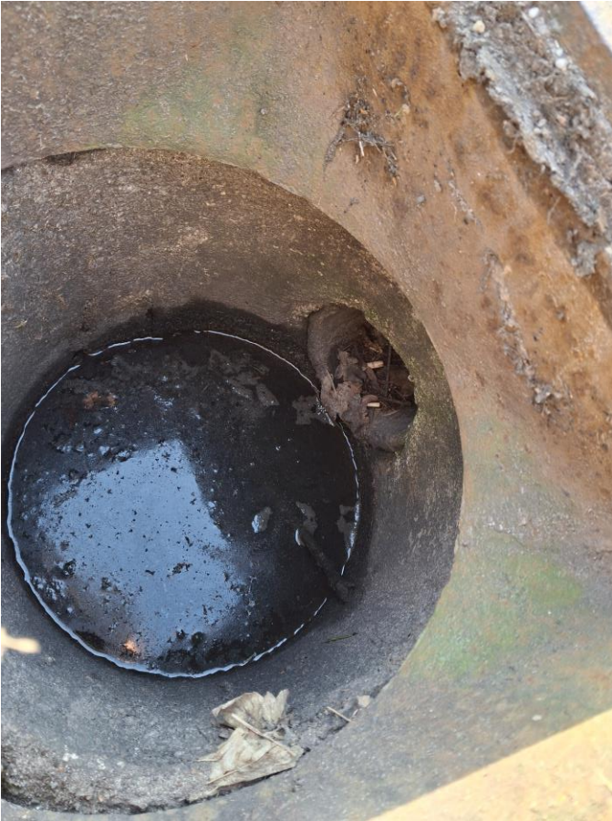
Figur 2-4. Undersökt dagvattenbrunn i anslutning till befintlig byggnad (foto: Vellinge Kommun).
