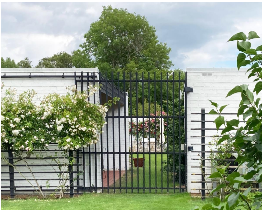
Tillbyggnad åt väster på Falsterbo 8:60 med genomgående öppning till atriumgård.
