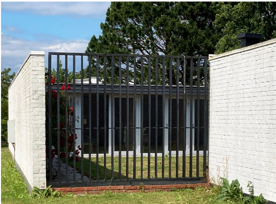
De ursprungliga husen hade endast ett fast galler, utan öppning, åt sydväst som tittade mot grannfastighetens "baksida". Endast på det nordligaste huset är detta utförande helt bevarat.
