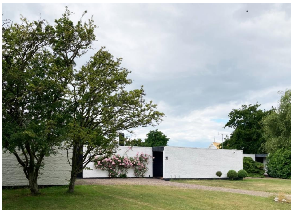
Fasaden mot Reinhold von Essens väg som skyddas i planförslaget.
