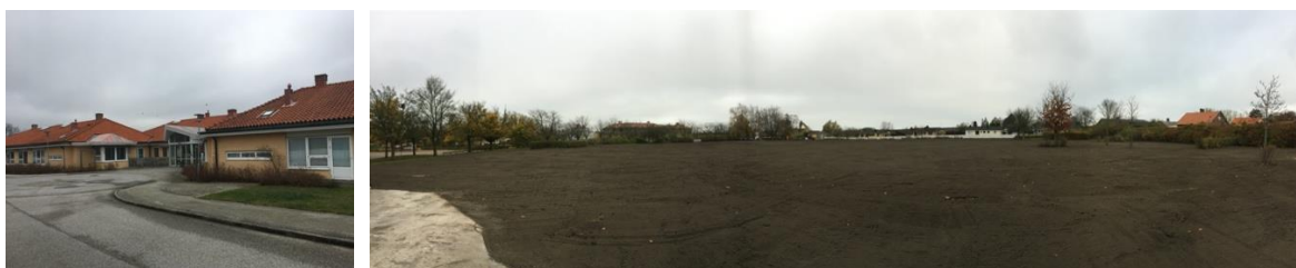
Bilden till vänster visar den västra entrén till Eskilsgården, numera rivet. Bilden till höger visar tomten efter rivning.
