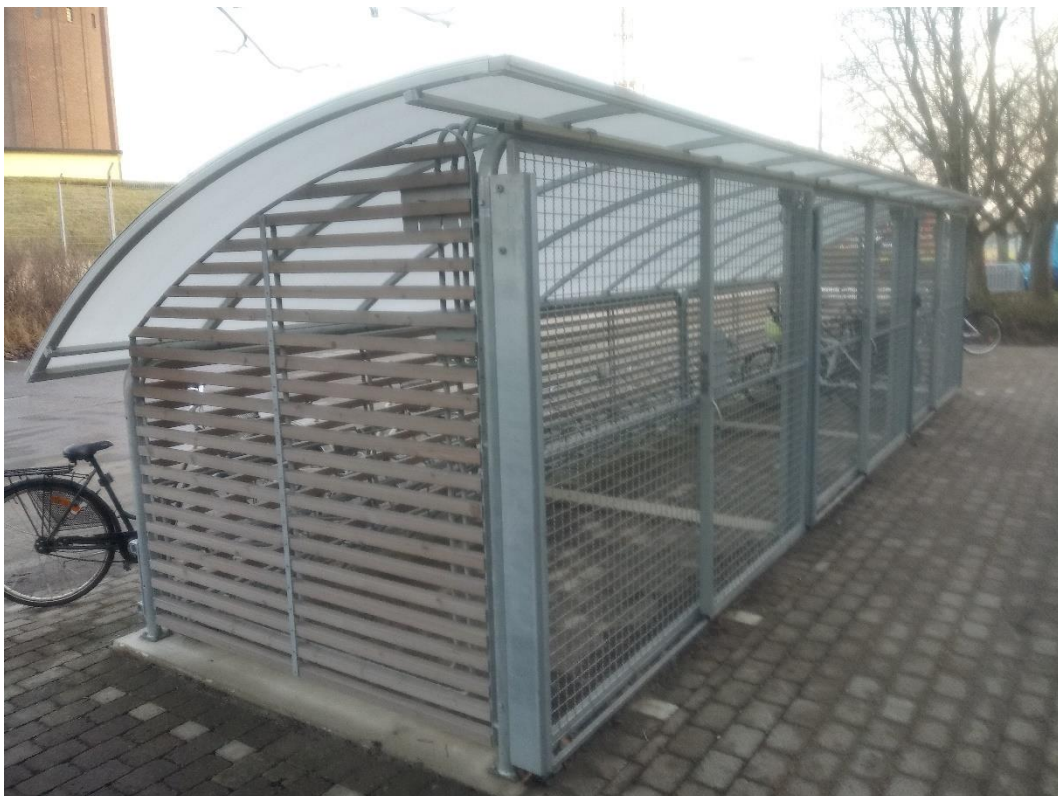
Figur 14. Exempel på väderskyddad cykelparkering där cyklarna endast nås av anställda med passerkort.
