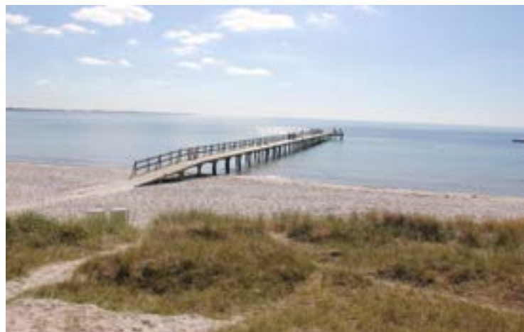
Badanläggning som ger möjlighet till bad och välbefinnande
