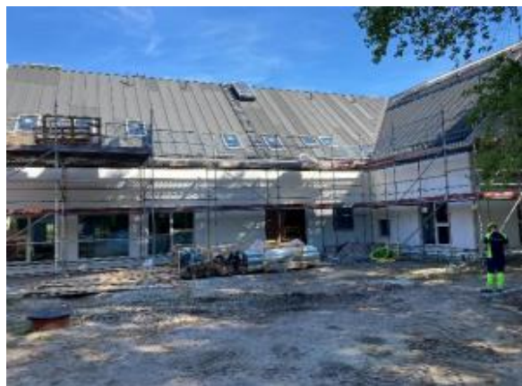
Byggnation av Skanörsgårdens förskola pågår
