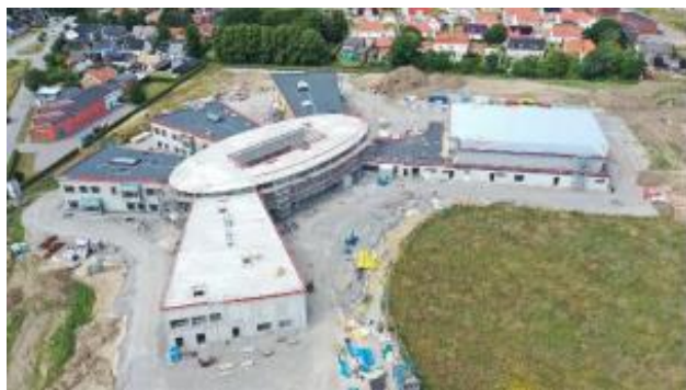
Pågående byggnation av ny grundskola i Hököpinge
