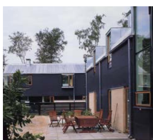
Smala huskroppar med flacka tak, spännande fönstersättning och mustig färgsättning - Viken
