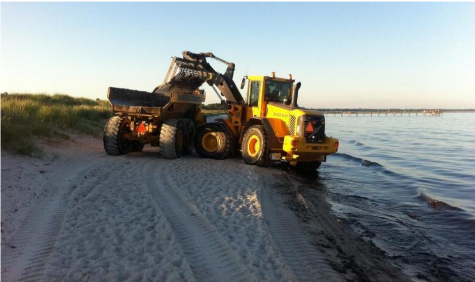
Figur 3-3 Rensning med hjullastare och gällerskopa
