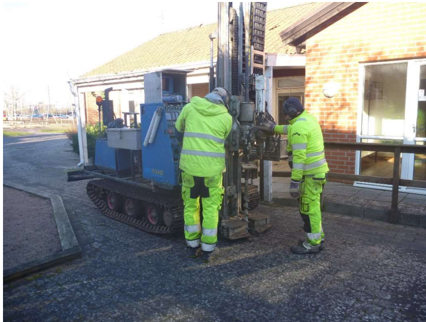
Figur 2. Provtagning med skruvborr monterad på bandvagn.
