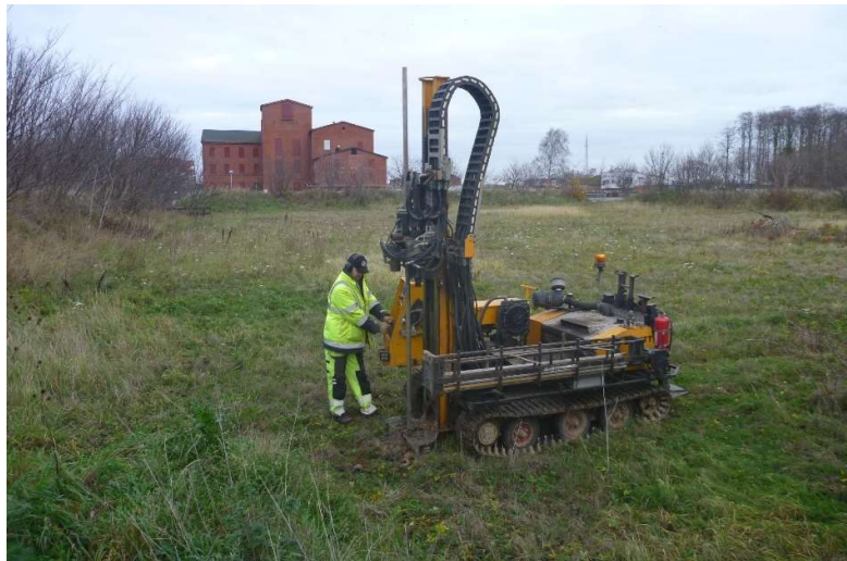
Figur 2. Provtagning med skruvborr monterad på bandvagn.
