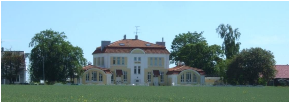
Nya skolan sett från norr
