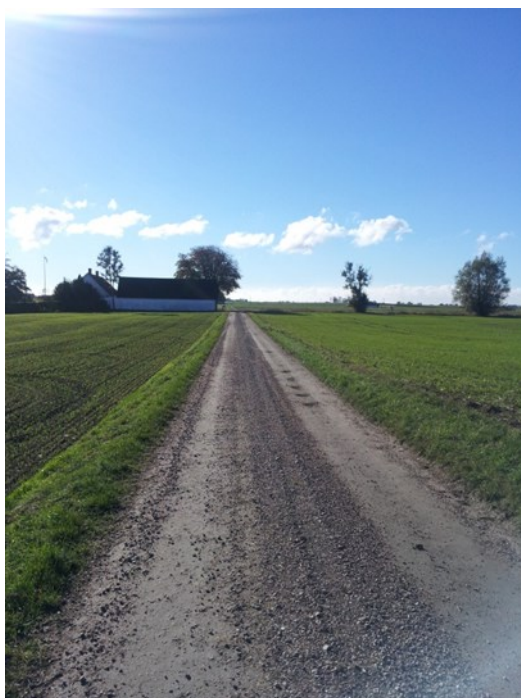
Figur 4. Niovägen, Arrie, enskild väg från Hötofta 9 till allmän väg 526/ 574, exempel på landsbygdsväg utanför tätbebyggt område.
