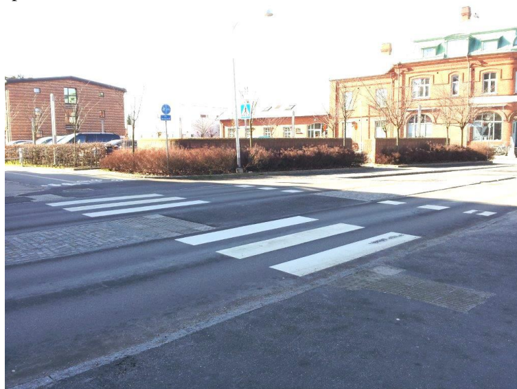
Bild 21 Trafiksäkerhetshöjande åtgärd i form av refug och upphöjd gång- och cykelpassage
