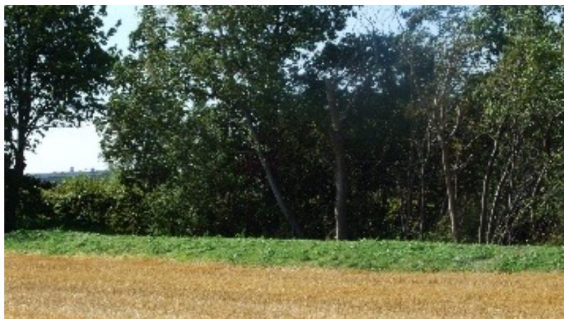
Vall vid Södervång i Vellinge som byggdes efter skyfallet 2014 och skyddar mot ytvatten från jordbruksmark.
